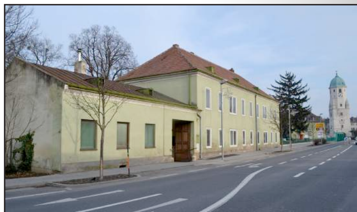
„Sanierungsfall“ Wiener Strasse 4
